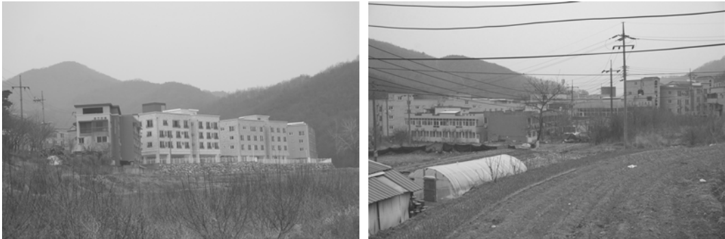
〈사진 33〉 금암리 일대의 주택 경관
