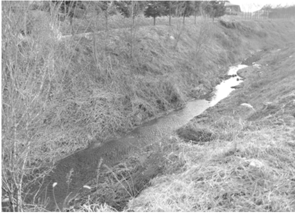
〈사진 12〉 신치천 전경
