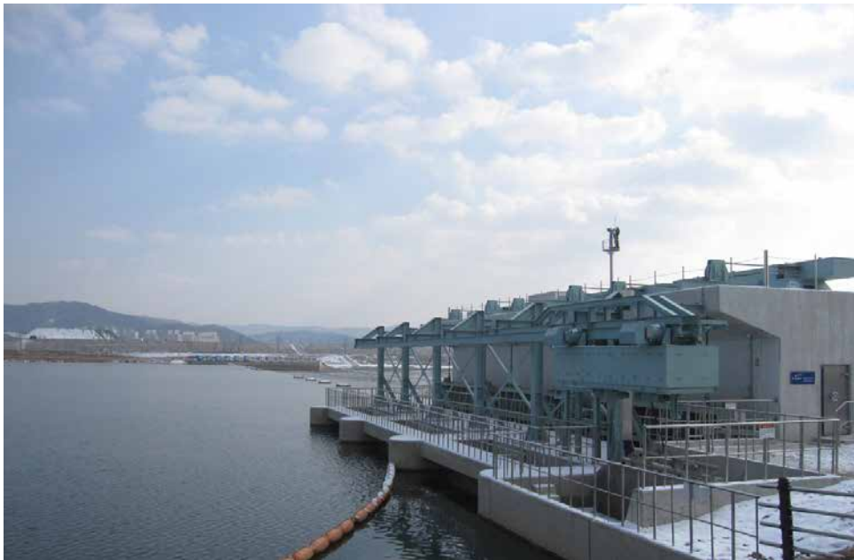
세종보에 설치된 수력발전소
