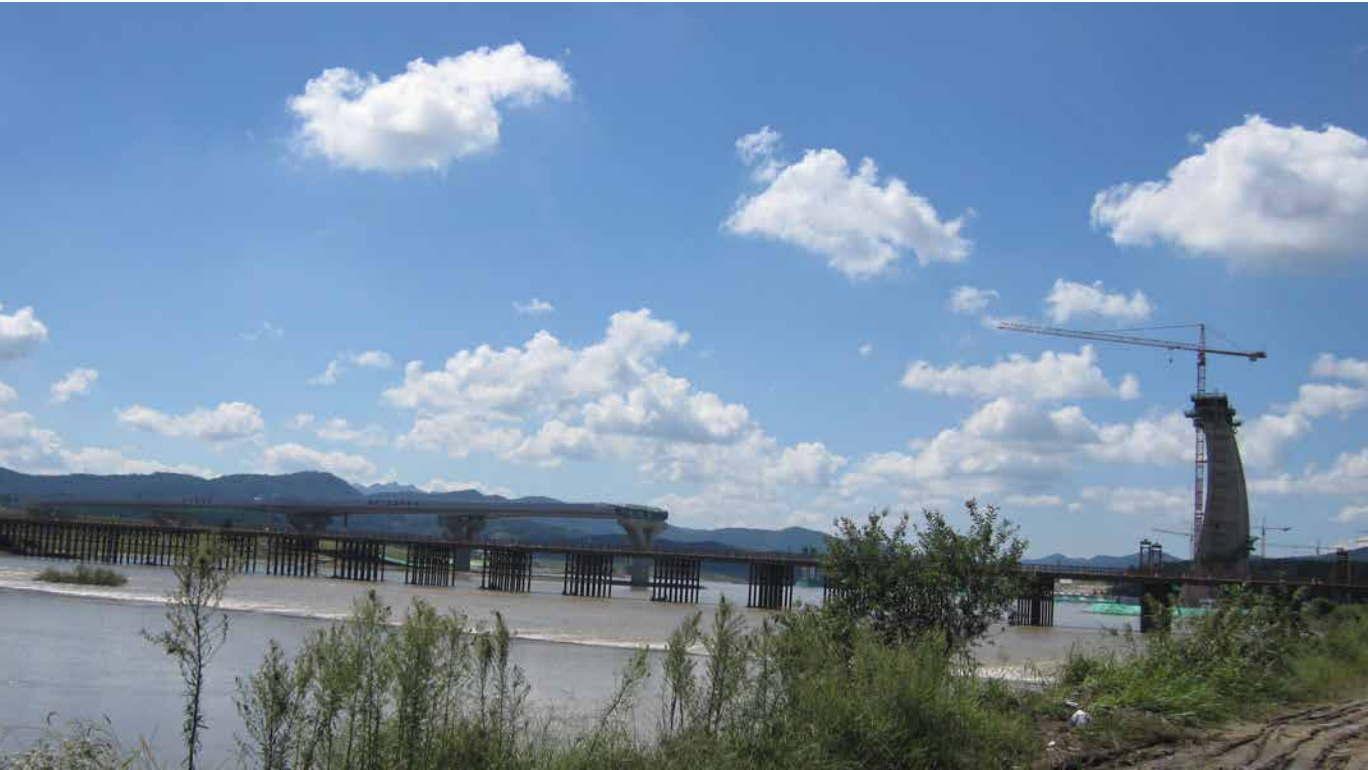
건설 중인 한두리다리
