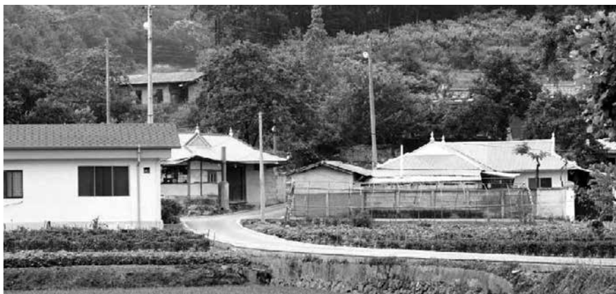
〈사진 88〉 송곡리 집촌의 내부구조 : 마을 안길의 포장 정리
